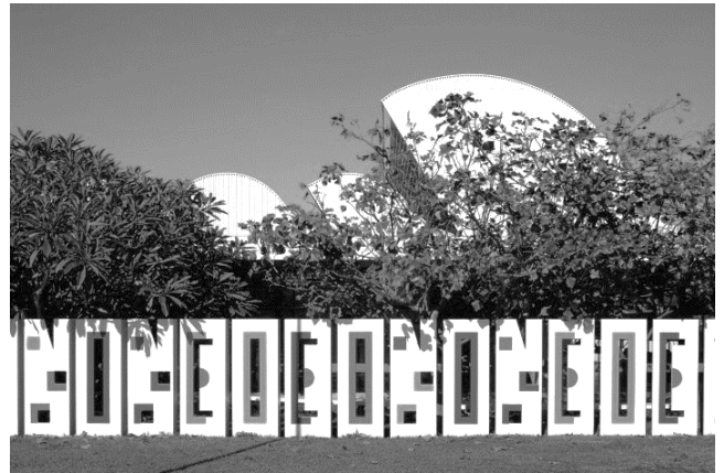
Athos Bulcão. Muro vazado em argamassa armada do Sarah Lago Norte (edifício principal, fachada oeste), Brasília, DF, 1998.
